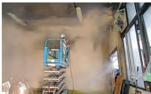
高圧洗浄機による洗浄
