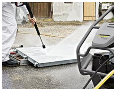
高温高圧洗浄機にて強力洗浄
