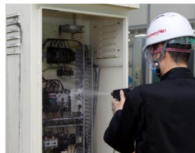
受配電盤洗浄
